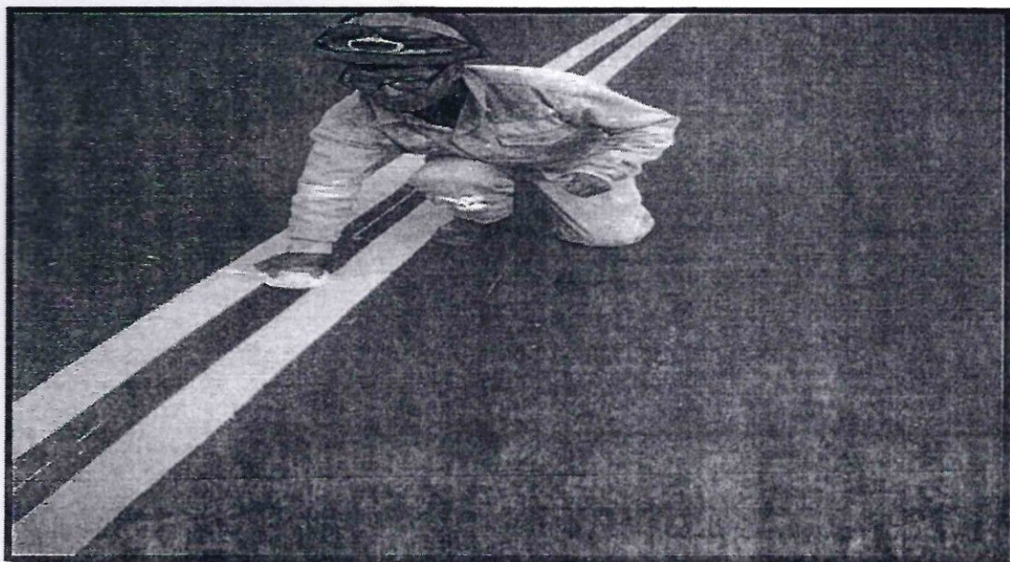
FOTO N° 06: SEÑALIZACIÓN Y SEGURIDAD VIAL: DELINEADORES REFLECTIVOS TACHAS
