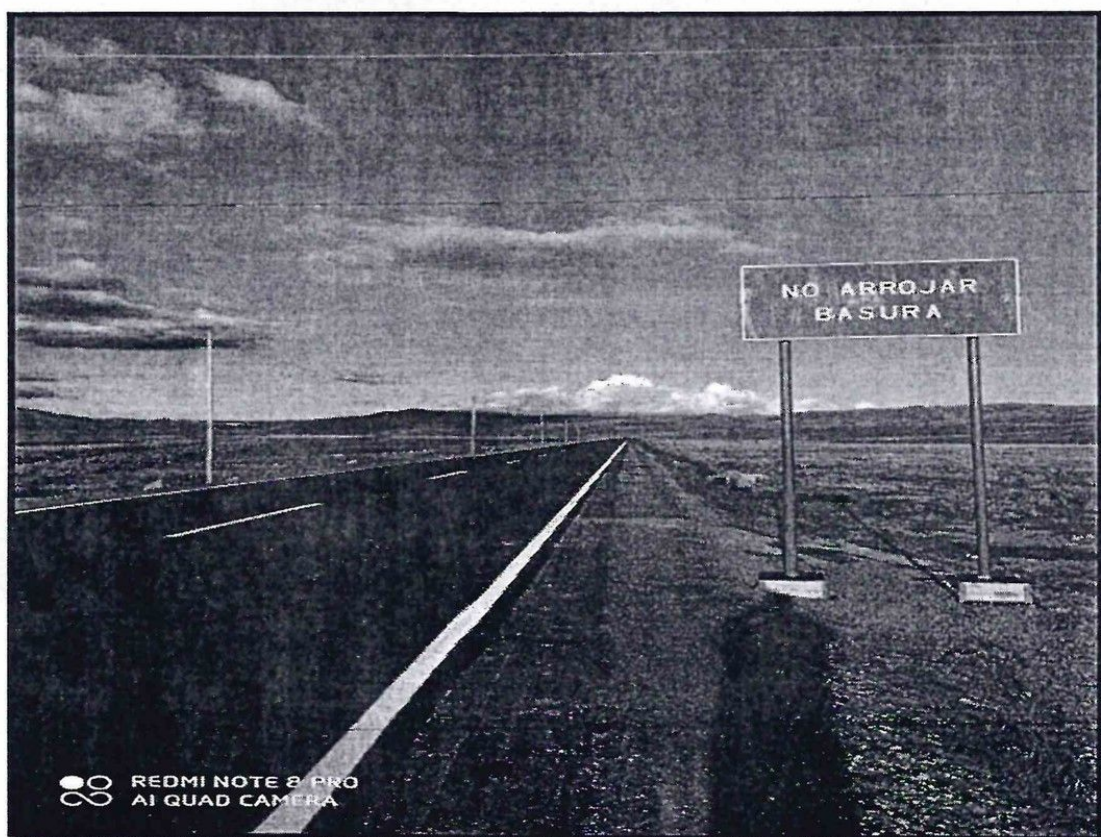
FOTO N° 05: SEÑALIZACIÓN Y SEGURIDAD VIAL: MARCAS EN EL PAVIMENTO
